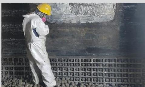
**Figura 13** Coordinaciones entre áreas & Instalación de revestimientos magnéticos
